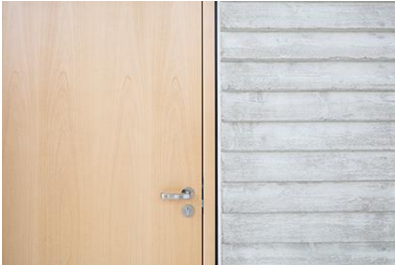
Bild 15: Materialkombination: Schörghuber Holztür mit Rotbuchen-Furnier und Beton-Stülpchalung.
